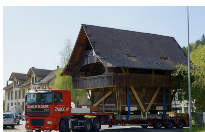
Speicher-Züglete. Oben links der alte Standort, wo der Speicher 47 Jahre lang stand. Auf- und Abladen und Stabilisieren sowie der Transport erfolgten durch die Firmen Zaugg und Bill, Rohrbach.
