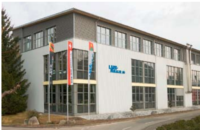
Firmengebäude mit neuem Obergeschoss (nach Minergiestandard).
